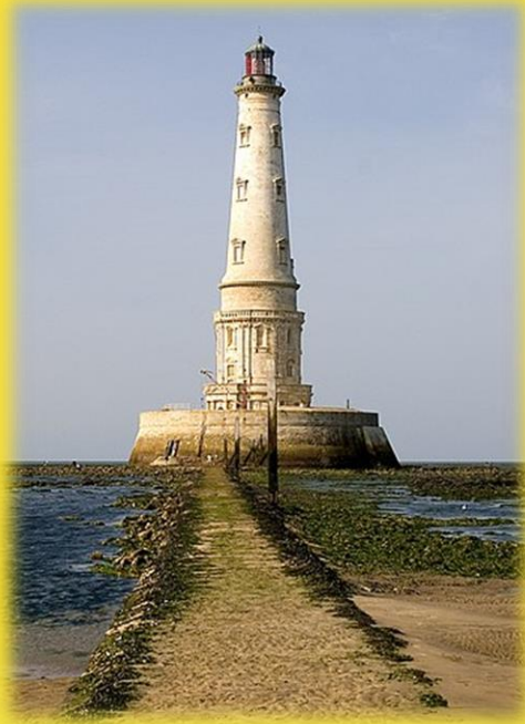
Le phare de Corduan est le plus ancien phare en activité de France. Construit entre 1584 et 1681, il se trouve dans le département de la Gironde.
